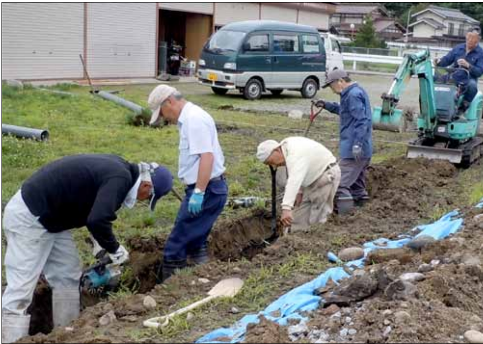
前庭排水改良工事 2020年7月
